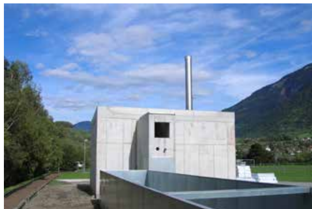
Autrefois complètement enterrée, la mise en conformité récente avec les dernières normes en matière d'émission de poussières fines laisse aujourd'hui apparaître un bâtiment de la centrale de chauffe contenant l'électrofiltre, image : Noble Bourgeoisie St-Maurice
